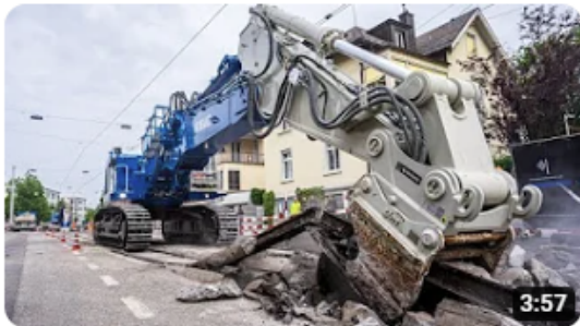
Gleisabbruch am Römerhofplatz
